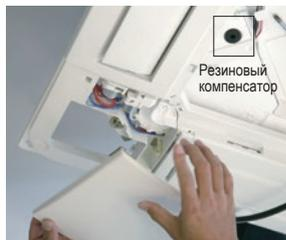
Снимите угловую крышку панели.
